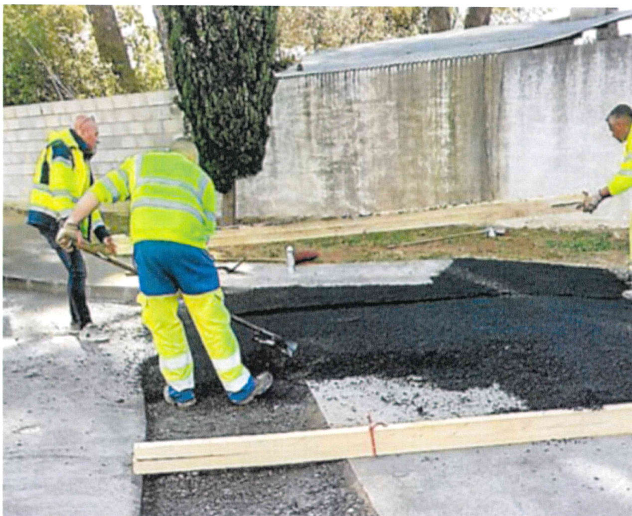
Création d'un ralentisseur chemin de Sommières.
